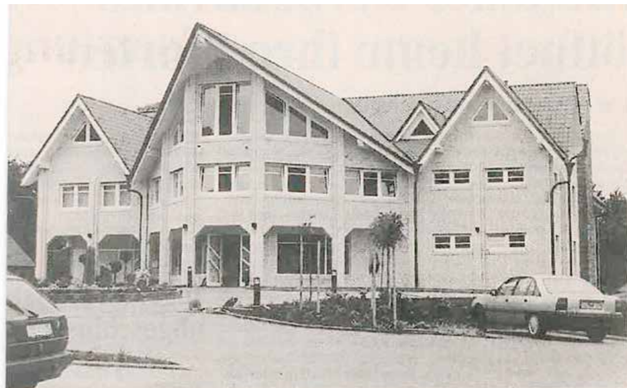
DER NEUBAU des HDS-Rechenzentrums am Lordsee in Ankum zeichnet sich durch eine ansprechende Architektur aus. Fotos: Geers
